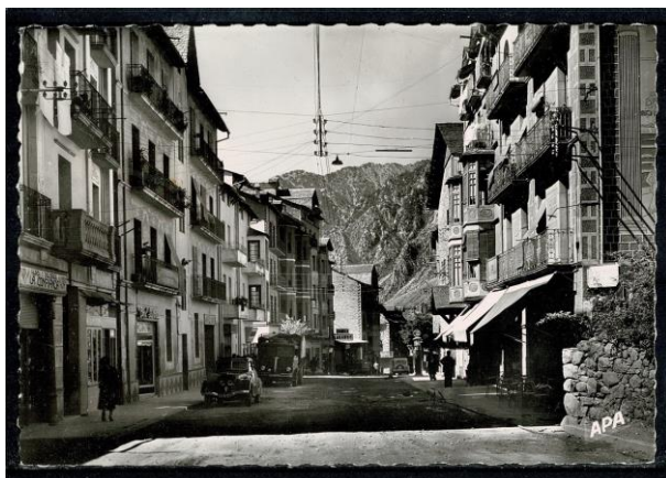
135 - VALLS D'ANDORRA Les Escaldes - Carrer Principal
