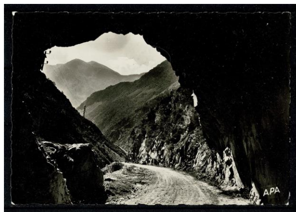
64 - VALLS D'ANDORRA Surtida del tunel carretera de la Massana
