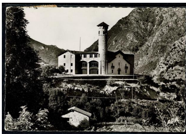
125 - VALLS D'ANDORRA Edifici de màquines de Radio-Andorra
